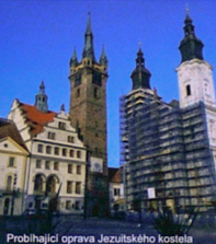
Probíhající oprava Jezuitského kostela
